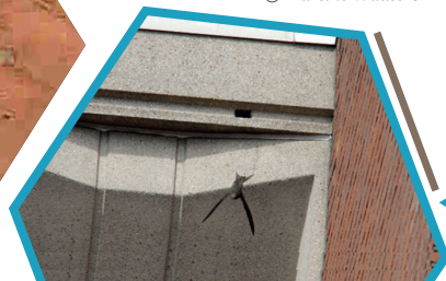
Redeplads under en vindueskarm © Martine Wauters
