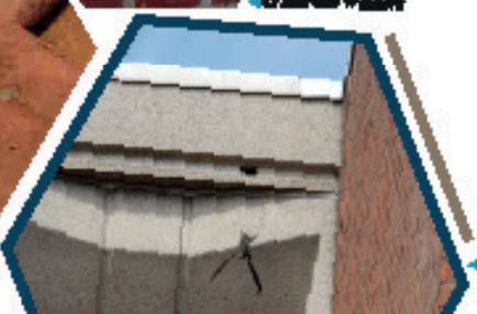
Boligplads under en søjle © M.H. Hall
