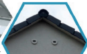
Wolfsberg-redesten i mur (Bredde 6) Høje-Mølle-Brick
